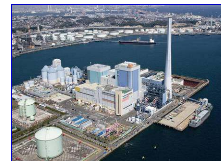
J-POWER 礪子火力発電所 写真提供: J-POWER[電源開発(株)]
