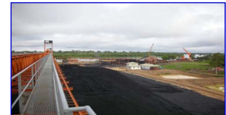
(中間ストックパイル)
